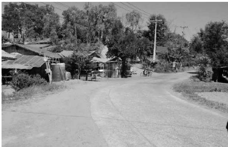
▲ ถนนคอนกรีตภายในหมู่บ้าน
